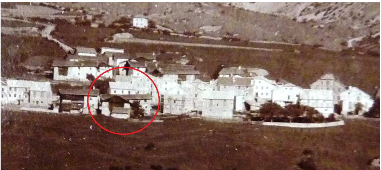
Foto intorno al 1898: la nuova casa d'abitazione è appena stata costruita, manca ancora il fienile. (Particolare di una fotografia storica, originale nell'Archivio dell'Abbazia di Marienberg).
